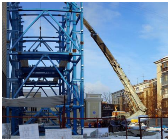
Строительство парковки башенного типа в Новосибирске
