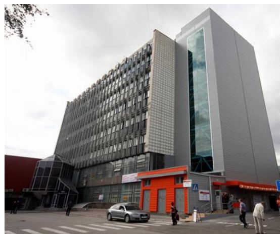
Механизованная парковка в Новосибирске
